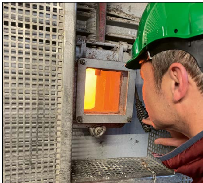
Abbildung 6: Brennraum des MHKW beim ZMS
