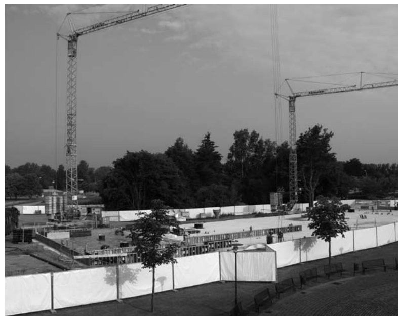
Das neue Hörsaalgebäude der HAW in Weiden entsteht.
